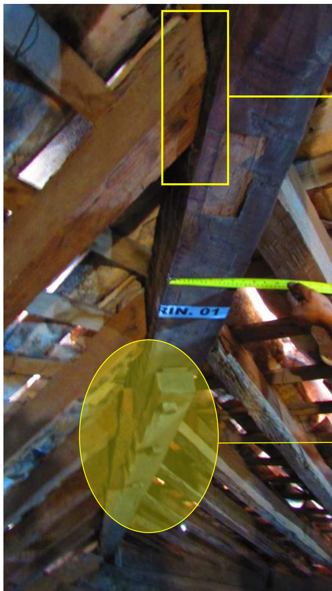
Figura 16 Vista interna da cobertura, mostrando estado de conservação do espigão.
