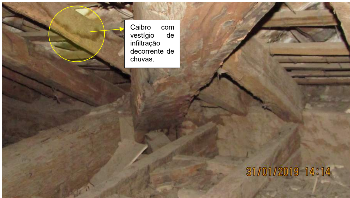
Figura 34 Caibro com anomalias especificadas.
