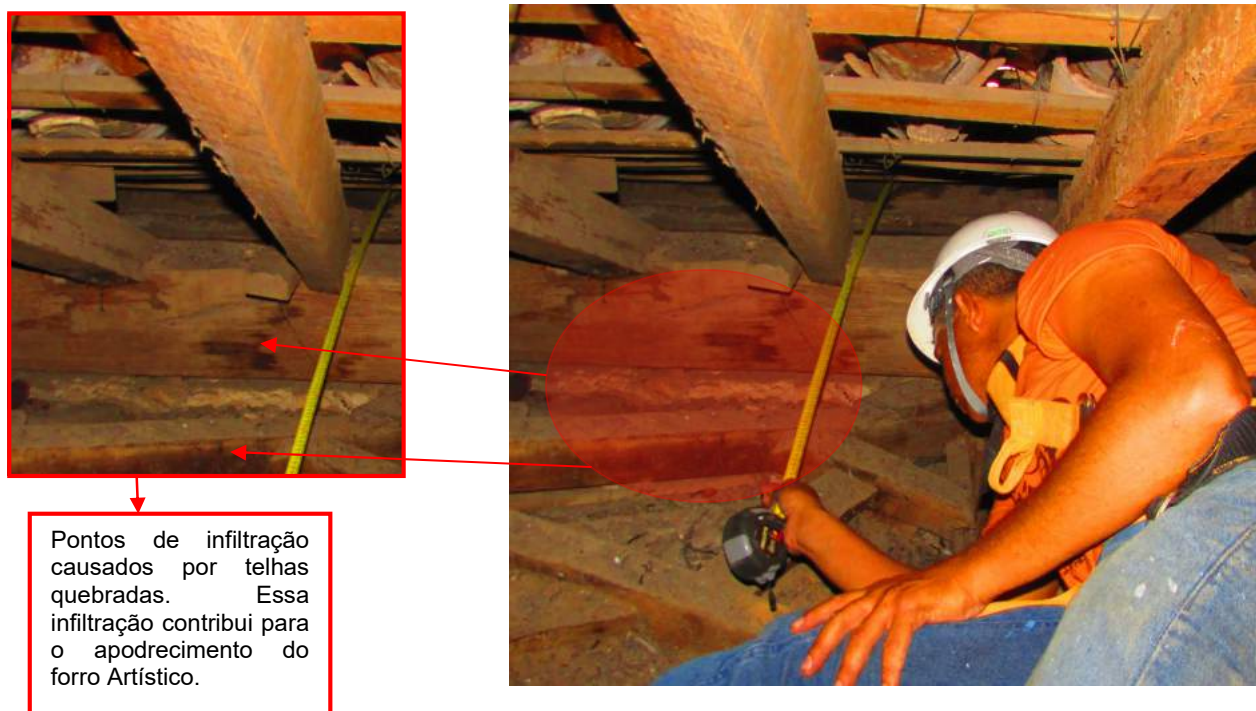
Figura 22 Vista interna da cobertura, com anomalias especificadas.
