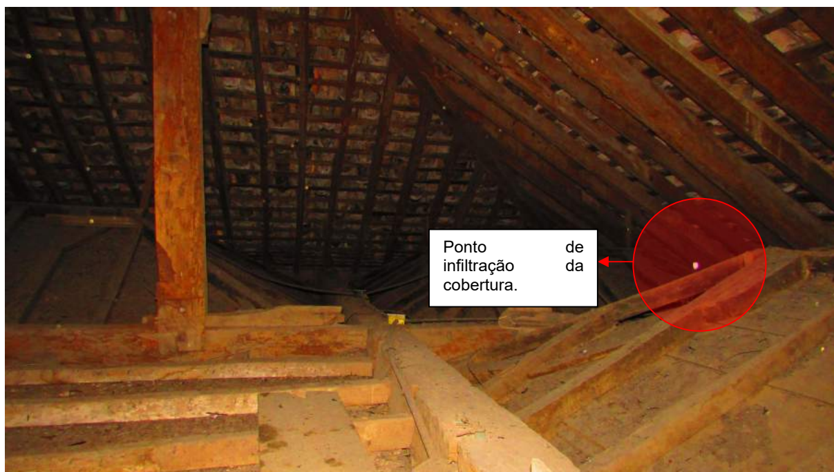
Figura 45 Vista interna da cobertura mostrando pontos de infiltração.
