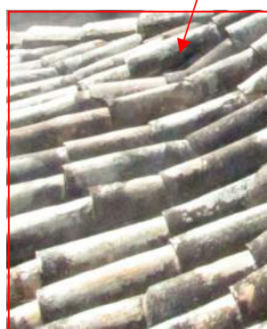
Figura 38 Vista externa da cobertura mostrando flambamento e anomalias especificadas. Foto: Gabriel Vidal, 12/11/18.
