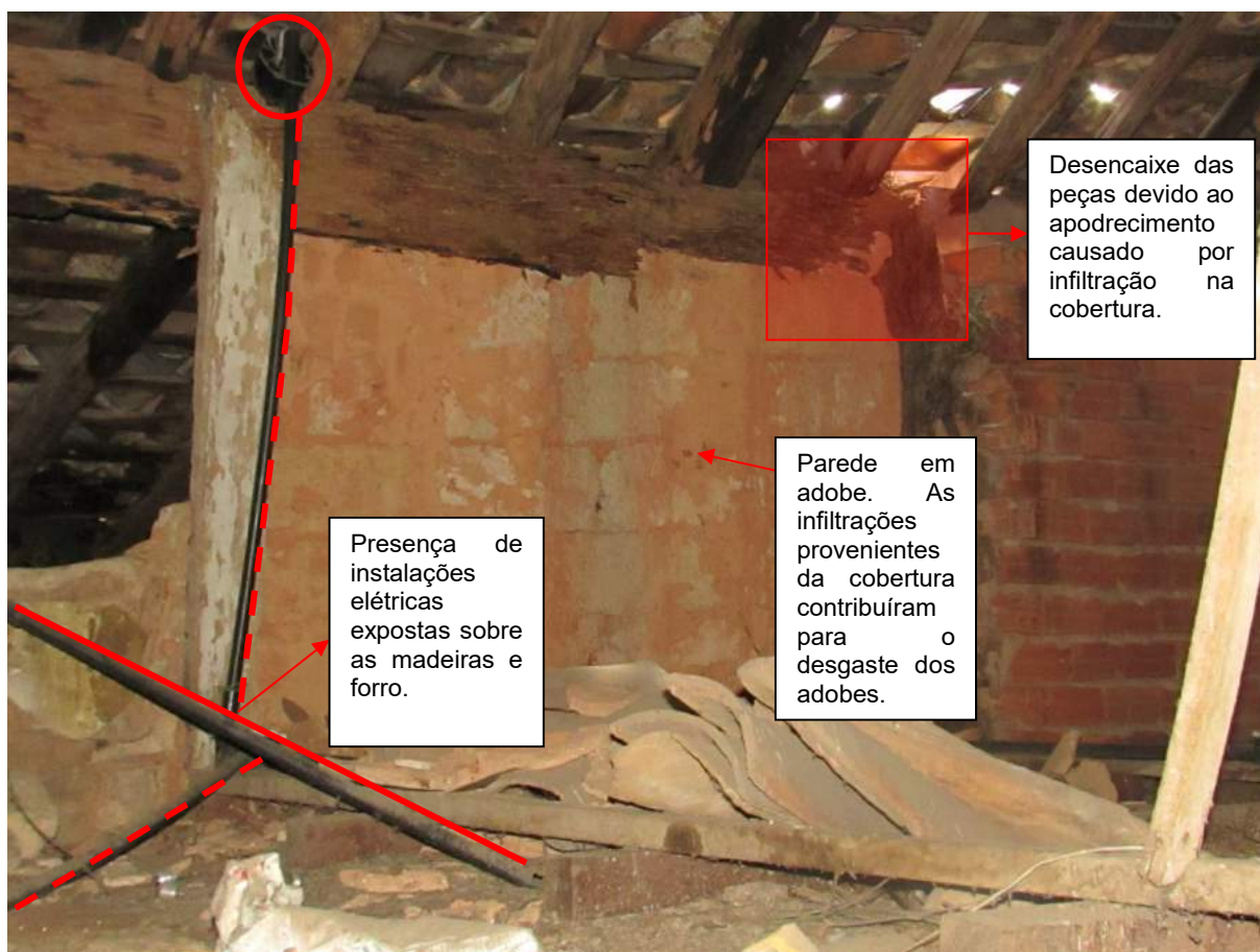
Figura 26 Vista interna da cobertura, com anomalias especificadas.
