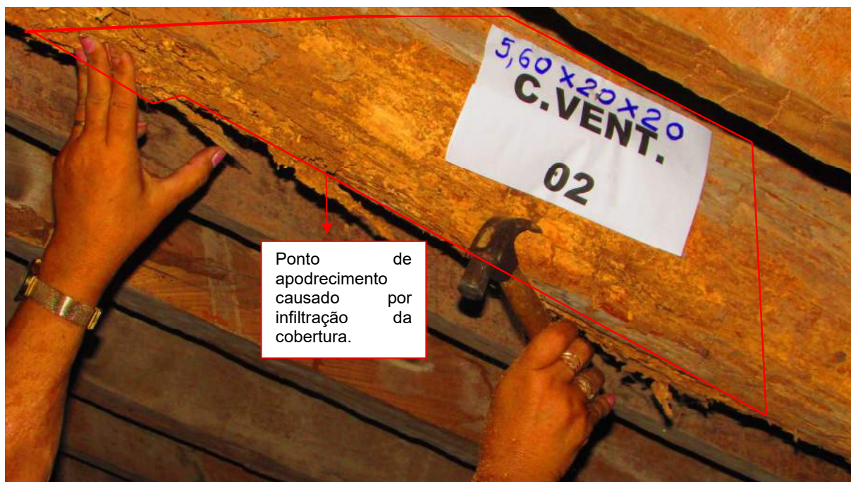
Figura 21 Vista interna da cobertura, mostrando anomalias na peça de contraventamento.
