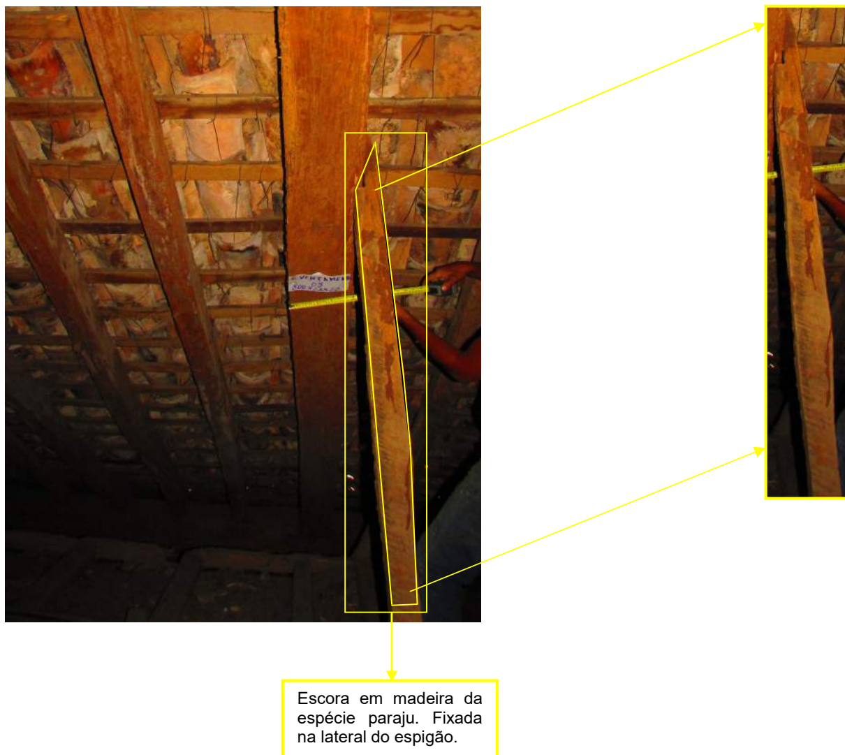
Figura 24 Vista interna da cobertura, mostrando escora. Foto: Gabriel Vidal, 12/11/18.
