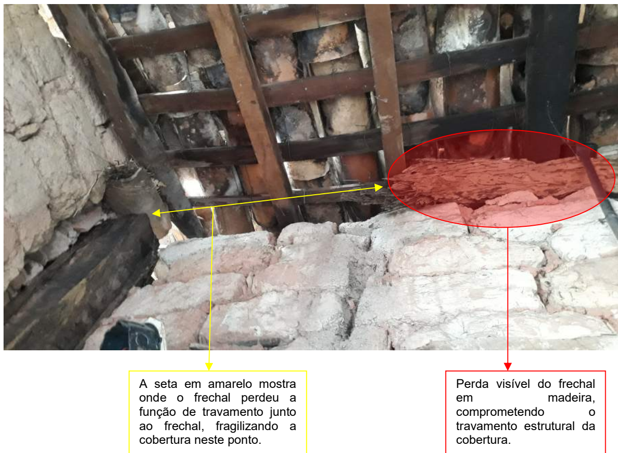
Figura 29 Vista interna da cobertura, mostrando anomalias no frechal. Foto: Gabriel Vidal, 12/11/18.
